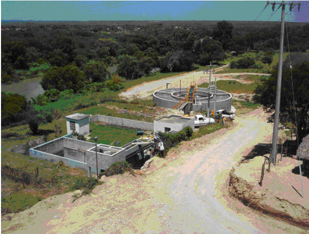
Vista panorámica de la planta
