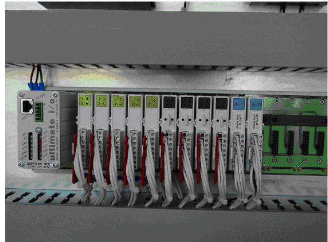
Controlador Ethernet 10/100 Mbps con 20 entradas digitales para 120 VCA, 16 salidas digitales para 120 VCA, 8 entradas analógicas 4–20 mA y 5 slots disponibles para futuras ampliaciones.
